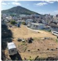
墓地整備工事中
